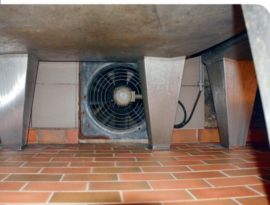
Der Ansaugpunkt muss an der tiefsten Stelle im Raum platziert werden.
