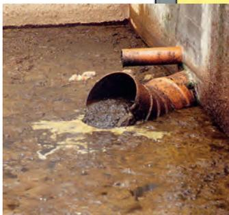
*Tauchrohre werden häufig nicht in einen Siphonsumpf geführt.*
