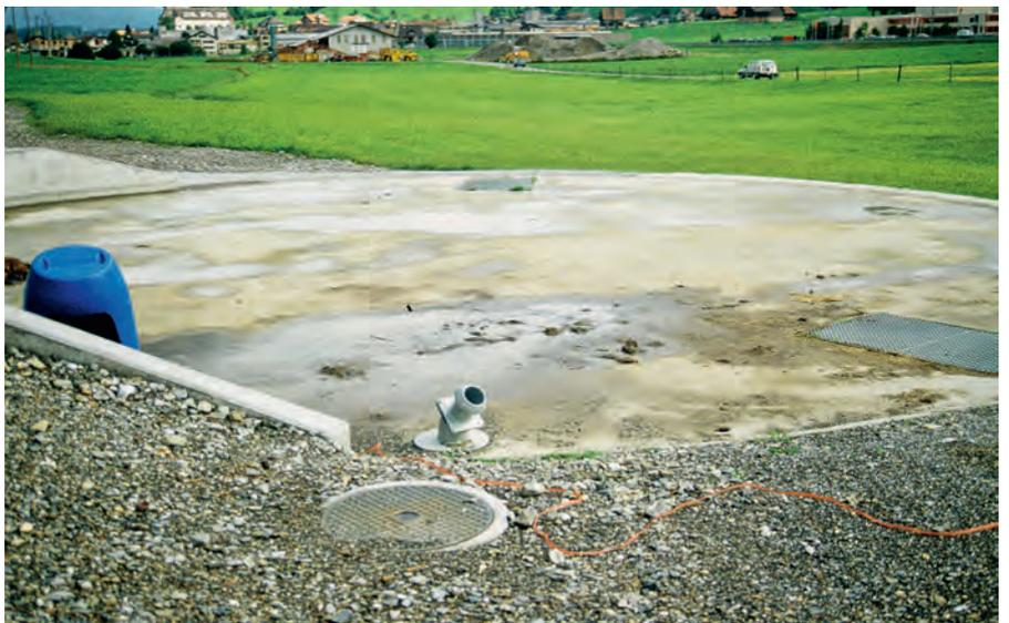
Bei einer neuen Gülleanlage lassen sich Entlüftungs- und Montageöffnungen, Rührwerk und Entnahmestelle für eine freistehende Grube optimal einplanen. Wird der feste Ansaugstutzen an der Durchfahrt platziert, sind weniger Retourfahrten nötig.
