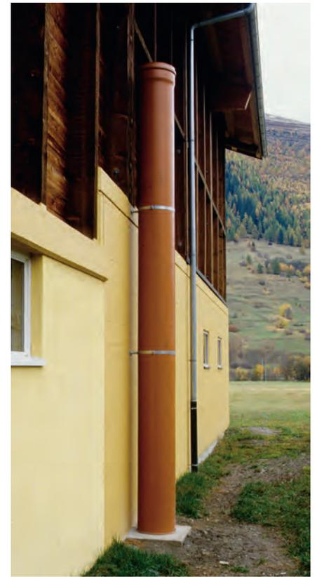
Können die Güllegase nicht gefahrlos über Entlüftungsöffnungen abgeführt werden, ist die Güllegrube zusätzlich durch einen Ventilator zu entlüften.
