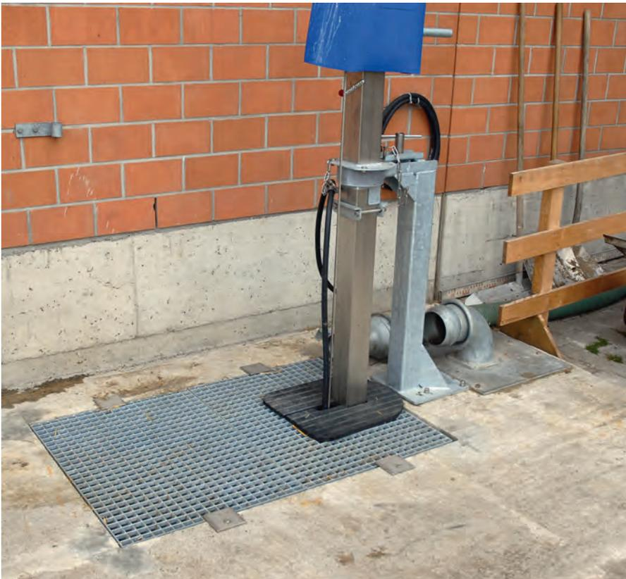
Für den Einstieg eignen sich Öffnungen von 80 x 120 cm. Der festgeschraubte Rost kann von Kindern und Tieren nicht entfernt werden. Für die Entnahme ist ein festinstalliertes Saugrohr die beste Lösung.
