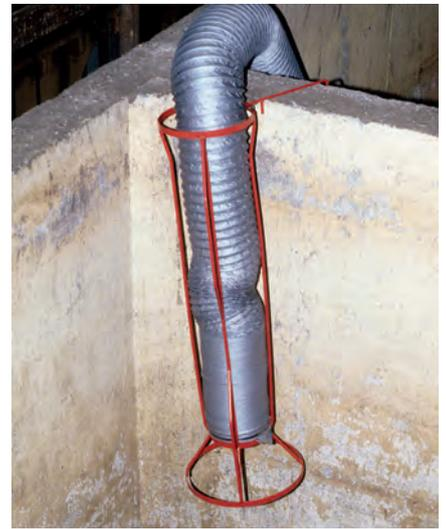
So ist der Schlauchbahnhof richtig eingehängt. Der Silo wird ausreichend durchlüftet.
