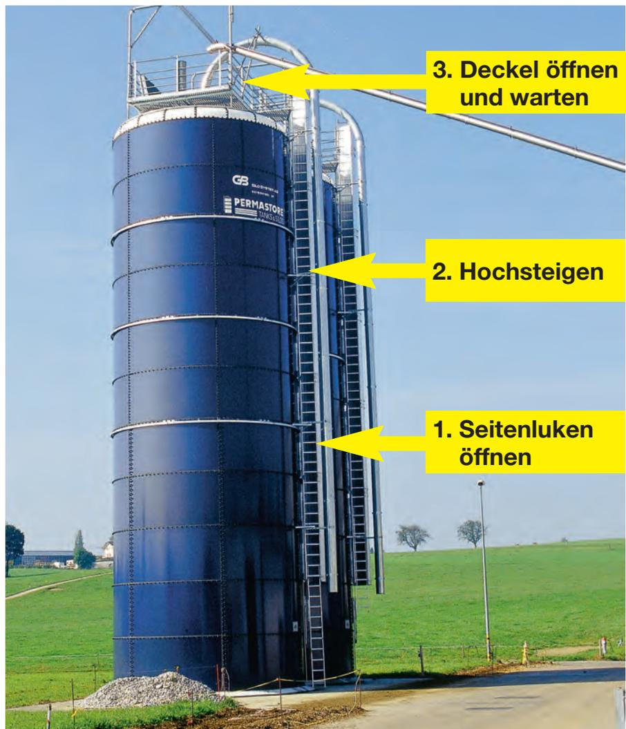
Vor dem Betreten des Gärfuttersilos die Abwurfluken und anschliessend den Tauchdeckel öffnen und mit dem Silohäcksler oder Gebläse durchlüften. Nach dem Öffnen der Abwurfluken nach oben steigen, weil die Schadgase nach unten abfließen.
