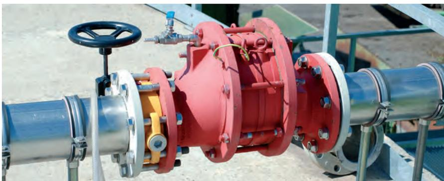
*Zwischen jedem Fermenter und Gasspeicher sowie unmittelbar vor jedem Verbraucher sind geeignete, leicht zugängliche Flammensperren in die Gasleitung einzubauen.*
