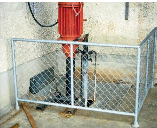
Mit einem Gitterzaun wird der Zugang zu den Gefahrstellen des Rührwerks oder von Pumpen einfach und sicher verhindert.
