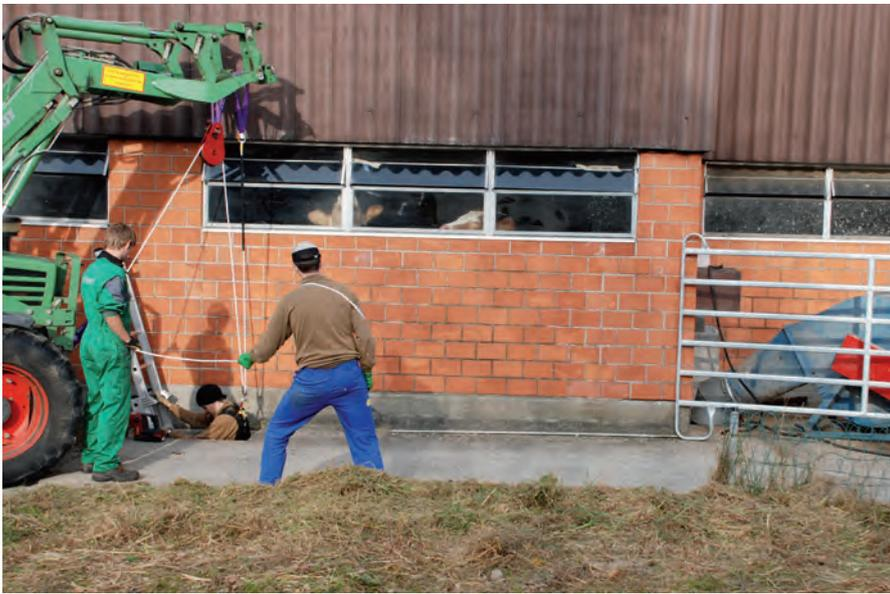
Wird die Grube mit einem Gebläse oder Ventilator gründlich durchlüftet, kann der Landwirt, gesichert durch mindestens zwei Personen, einsteigen. Ein Auffanggurt, Umlenkung und Übersetzung des Sicherungsseils sind zwingend nötig.
