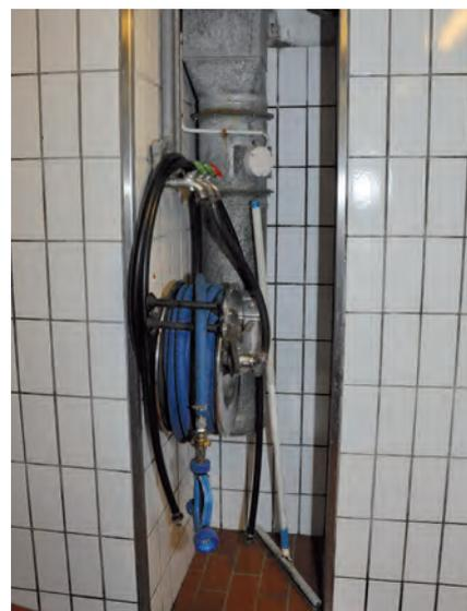
*Wesentlich komfortabler sind festinstallierte Absauganlagen. Sie können über Schalter oder Gasfühler gesteuert werden.*
