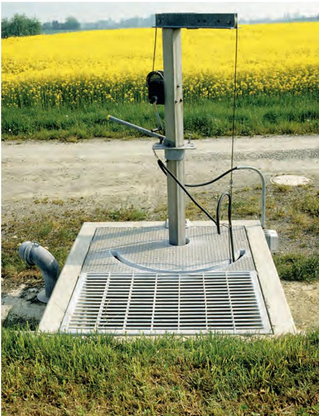
Rührwerke müssen von aussen bedient werden können. Eine sichere Rostabdeckung dient zur Entlüftung und Kontrolle.
