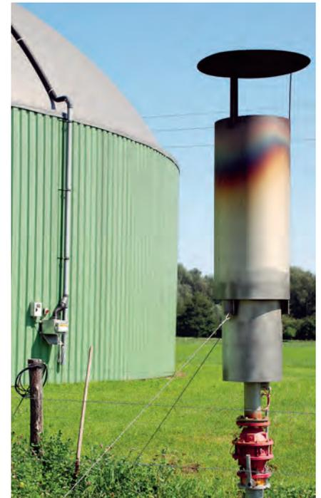
*Biogasanlagen müssen einen zweiten Verbraucher haben, über den ggf. die gesamte Gasproduktion verbrannt werden kann. Der zweite Verbraucher muss auch dann betrieben werden können, wenn die Gasleitung zu Gasbehälter und Verbraucher ausser Betrieb gesetzt wird.*
