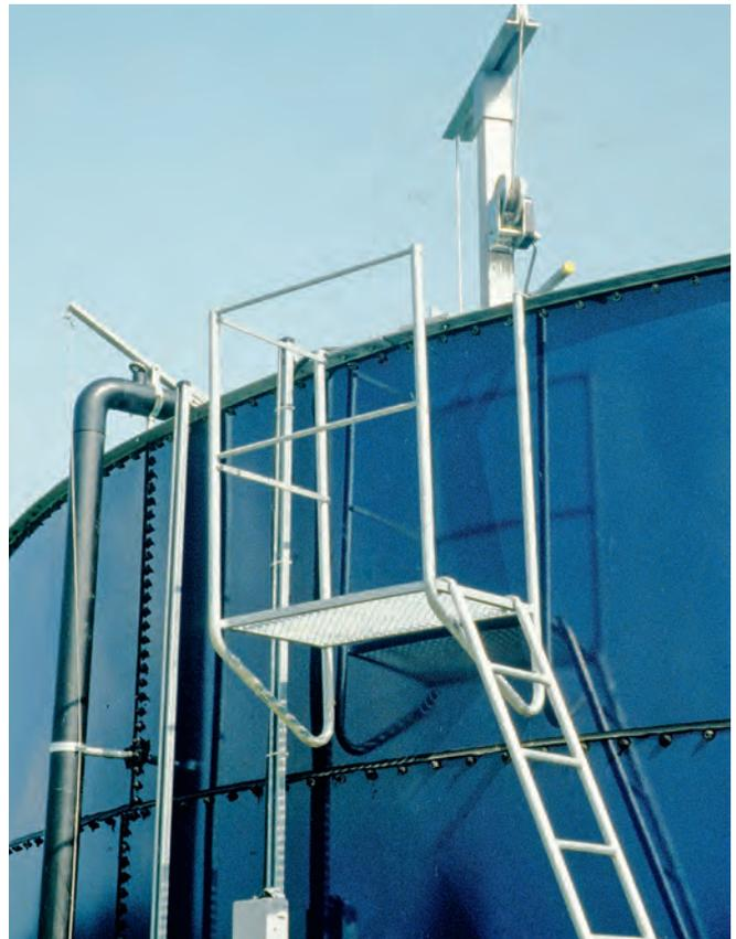
An Güllesilos ist für das Rührwerk ein Bedienungspodest erforderlich. Die einhäng- und wegnehmbare Leiter eignet sich als kindersicheren Zugang.
