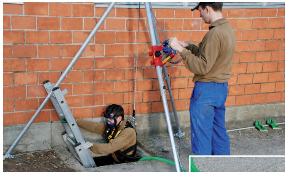
Mit einem Frischluftgerät kann auch ohne Durchlüftung in eine Grube eingestiegen werden. Auskunft: landw. Bildungszentren, Feuerwehr, BUL/agriss.
