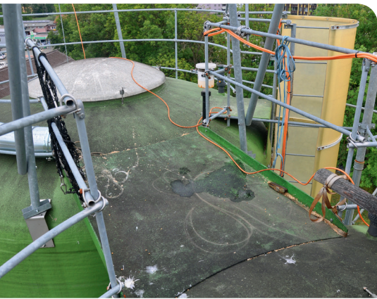
Hochsilos der gleichen Höhe müssen mit einem Laufsteg verbunden sein.
