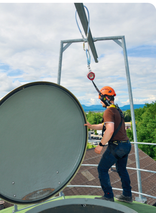
Personensicherung an der Kranbahn mittels Anschlagsschlinge, Stahlkarabiner, Höhensicherungsgerät, Falldämpfer und Auffanggurte.
