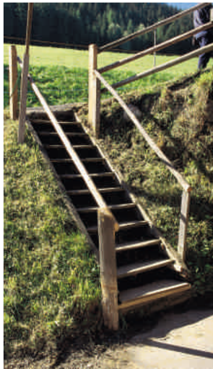
Ausstertreppen müssen sicher begehbar sein. Nebst einem Handlauf ist auf griffige Stufen zu achten, selbst bei Nässe und Glätteis.
