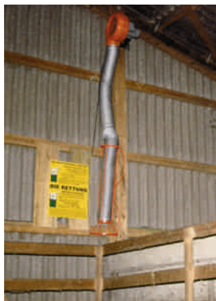
Sind die Siloluken nicht im richtigen Abstand angebracht, ist ein fest ange- brachtes Silogebälde zu montieren, damit die Silos durchlüftet werden können.
