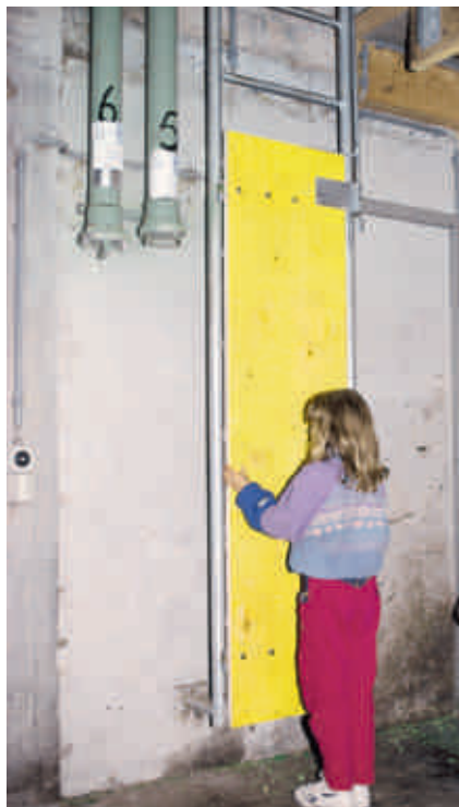
Eine Kindersicherung kann z.B. durch das Einhängen eines Brettes oder einer Schalttafel erreicht werden.
