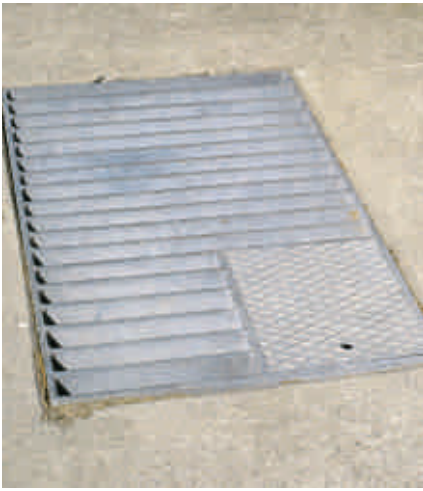
Befahrbarer Rost mit einer kleinen Öffnung für den Saugschlauch.
