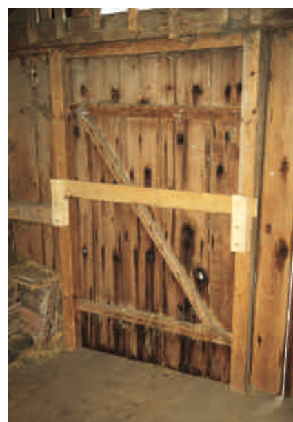
Besteht beim Öffnen von Türen von Wandöffnungen Absturzgefahr, müssen diese mit einem Querriegel versehen sein. Dies ist nötig, wenn die Wandöffnung höher als 130 cm ist. Dieser Riegel darf an Belade- oder Entladestellen aufklappbar oder verschiebbar sein.
