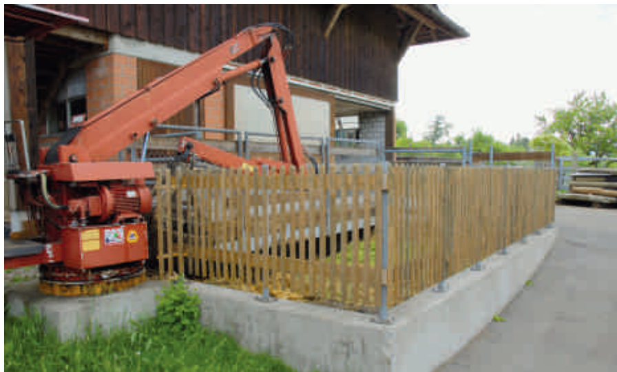
Hofplätze müssen so gestaltet sein, dass Kinder nicht gefährdet sind. Gefahren lauern durch ungeschützte Maschinen, Tiere, Gruben und Fahrzeuge.
