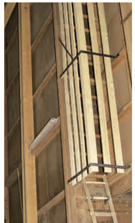
Aufstieg mit Rückenschutz zu einem Heustock. Ein solcher ist bei Leiterhöhen über 5 m erforderlich.
