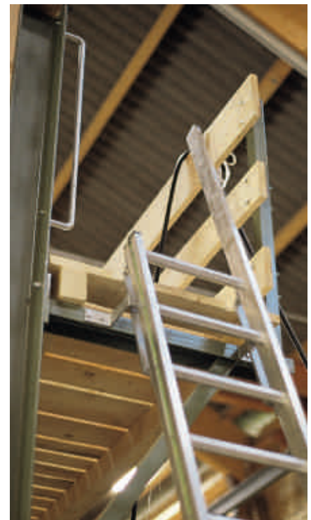
Leiterhaken zum Einhängen am Bügel eines erhöhten Bodens. Für einen sicheren Übertritt braucht es Haltebügel.
