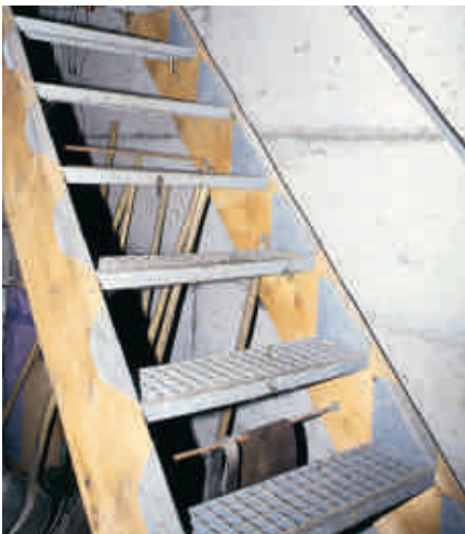
Treppen lassen sich in Eigenleistung erstellen, insbesondere mit vorgefertigten Rosten, welche sich leicht an Holmen festschrauben lassen.
