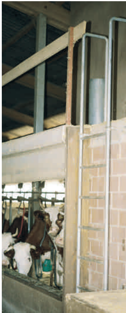
Gesicherte Aufgänge in Form einer senkrechten Leiter mit guten Handgriffen oder zum Besteigen des Heubelüftungsstockes. Der Abstand einer senkrecht zur Wand montierten Leiter muss an der engsten Stelle mindestens 15 cm betragen.
