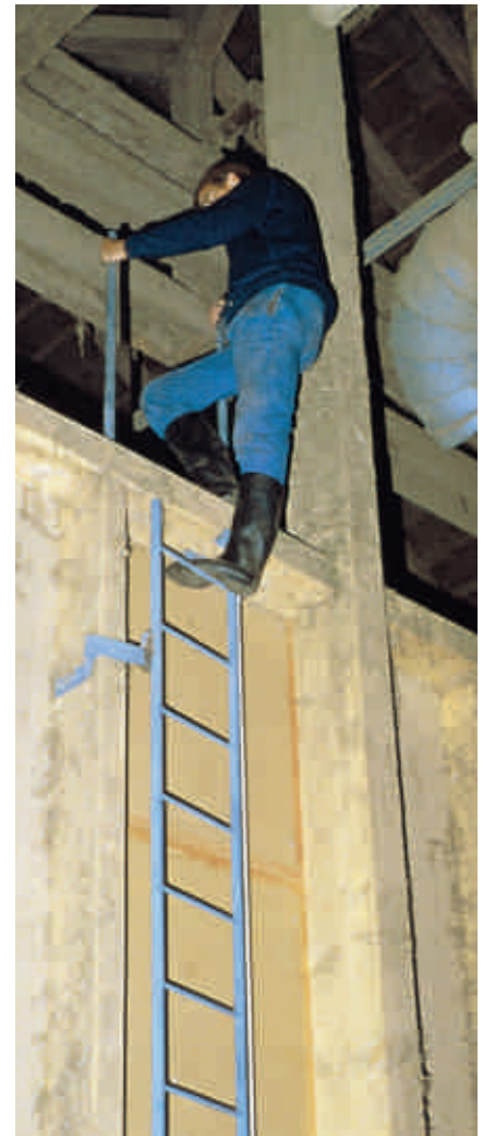
Gesicherte Aufgänge in Form einer senkrechten Leiter mit guten Handgriffen oder zum Besteigen des Heubelüftungsstockes. Der Abstand einer senkrecht zur Wand montierten Leiter muss an der engsten Stelle mindestens 15 cm betragen.
