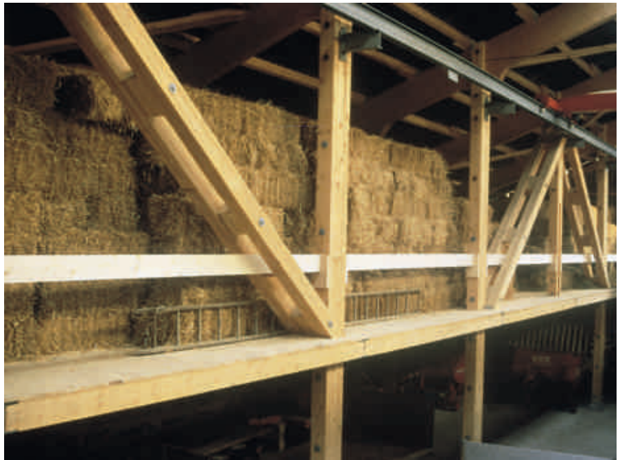
Sinnvoll in die Baukonstruktion eingefügtes Geländer. Es ist so zu dimensionieren, dass die zu erwartenden Kräfte aufgefangen werden.
