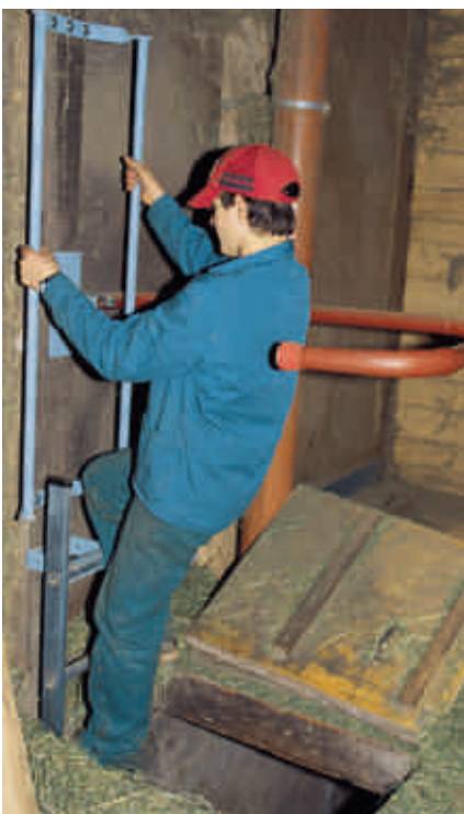
Aufstieg mit gesicherter, senkrechter Leiter. Der rote Bügel dient als Sicherung für die Abwurfklappe.
