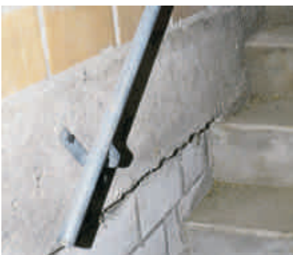
Idealer Handlauf, bei welchem die Hand ohne an der Befestigung anzustossen, gleiten kann.
