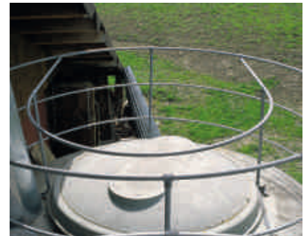
Damit Personen nicht nach innen stürzen, ist auf der Innenseite ebenfalls ein Gelän- der angebracht.
