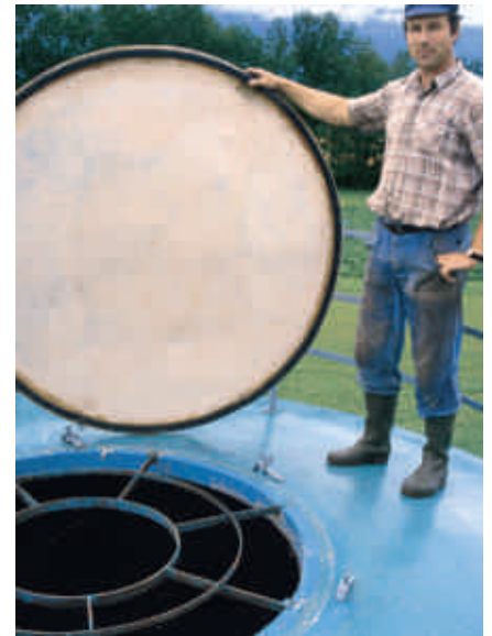
Damit Personen nicht nach innen stürzen, ist unter dem Tauchdeckel ein Sicherheits- rost eingebaut. Das begehbare Silodach muss eine trittsichere Oberfläche und 3 Geländerringe aufweisen.
