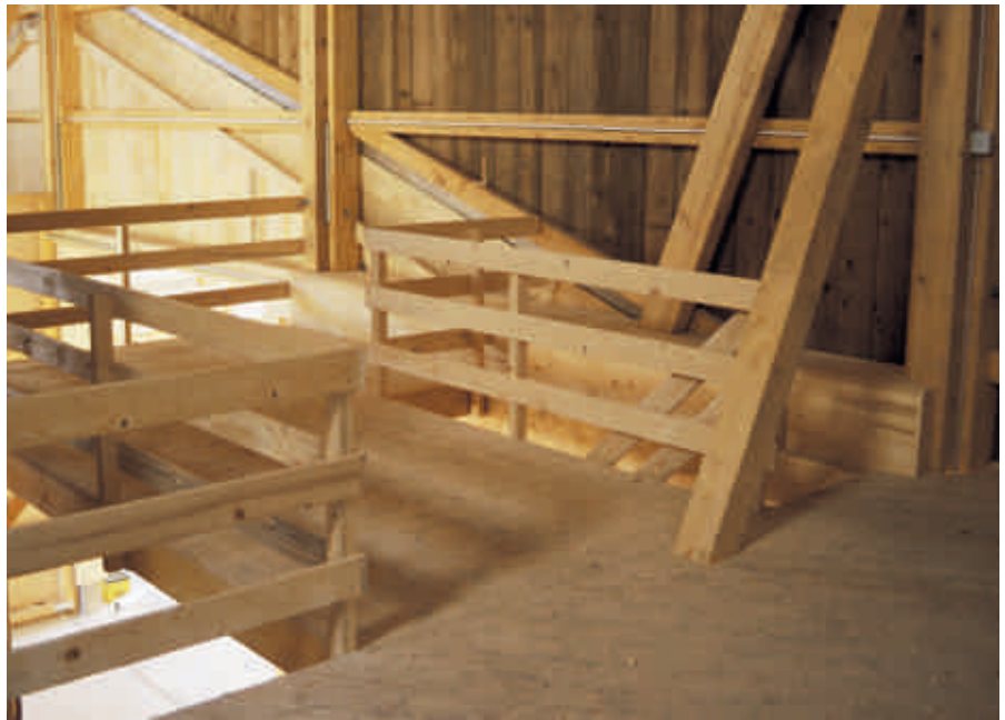
Alle überhöhten Böden müssen mit Geländern gesichert werden. Gutes Beispiel mit Geländern und Treppenhandlauf.
