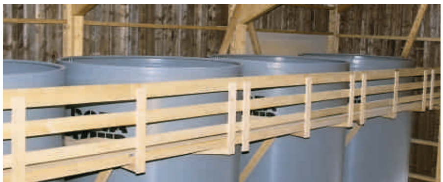
Ein Laufsteg kann auch an Kunststoffsilos angebracht werden. Er muss 100 cm unterhalb der Krone montiert werden.
