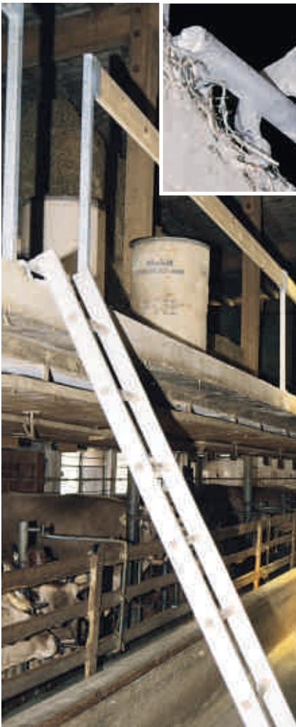
Gesicherter Aufstieg mit wegnehmbarer Leiter und Geländeröffnung als Durchtritt.
