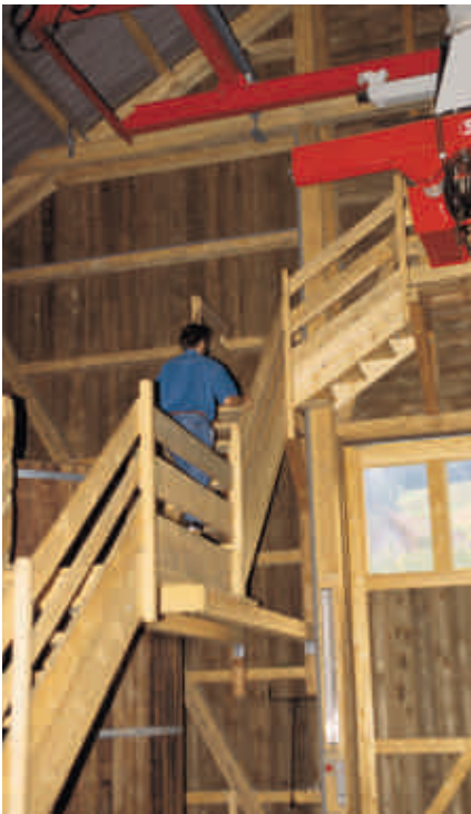
Gutes Beispiel eines einfachen Aufstiegs zu einem Greifer. Wird ein solcher in die Planung integriert, lässt er sich problemlos verwirklichen.
