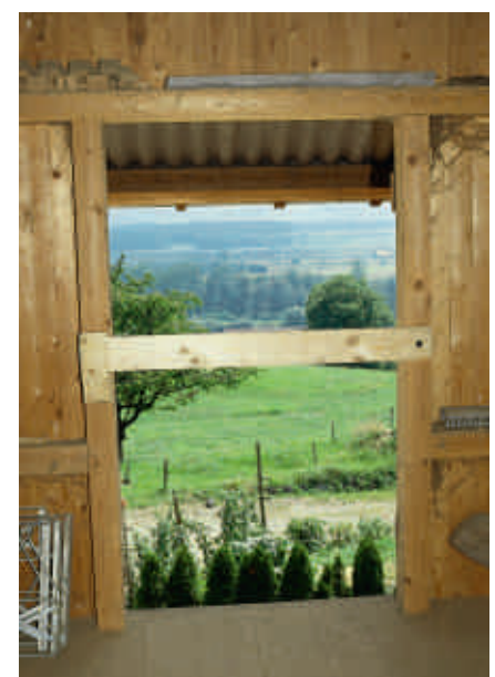
Besteht beim Öffnen von Türen von Wandöffnungen Absturzgefahr, müssen diese mit einem Querriegel versehen sein. Dies ist nötig, wenn die Wandöffnung höher als 130 cm ist. Dieser Riegel darf an Belade- oder Entladestellen aufklappbar oder verschiebbar sein.
