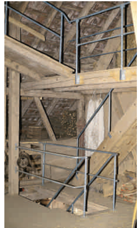
Wer entsprechende Möglichkeiten hat, kann Treppenanlagen auch in Metall erstellen. Diese lassen sich oft besser an die Vorgaben anpassen.
