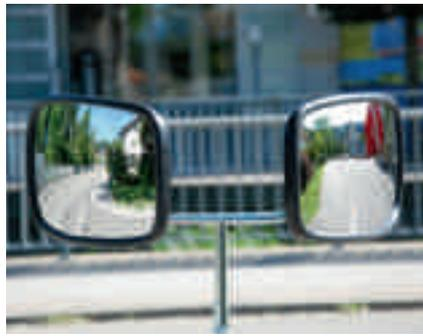
Neu angebrachte Seitenblickspiegel müssen eine Spiegelfläche von je 500 cm<sup>2</sup> aufweisen und im Querformat montiert sein.
