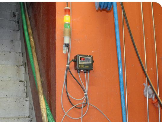
Les appareils de mesure surveillent en permanence le taux de CO<sub>2</sub> dans l'air et donnent l'alerte en cas de danger.
