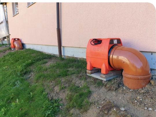
*Le point de sortie des gaz aspirés et le point d'aspiration de l'air frais doivent être séparés.*
