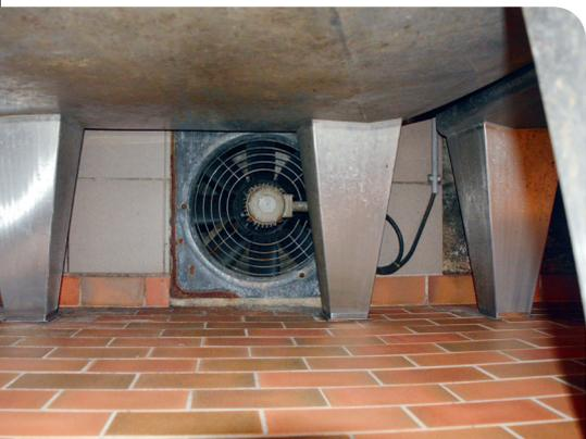
*Le point d'aspiration doit être placé à l'endroit le plus bas de la pièce.*
