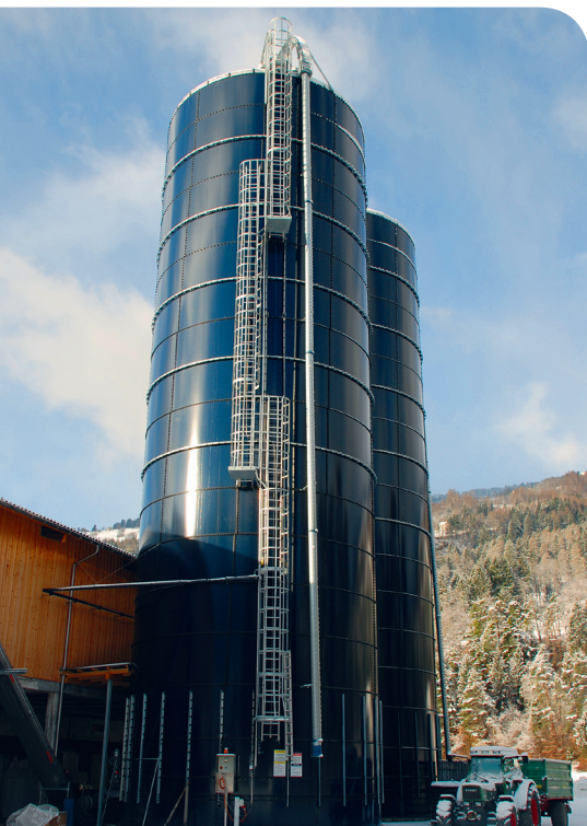
Accès au sommet d'un silo tour avec plateformes intermédiaires
