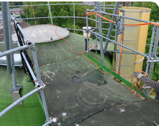
Les silos hauts de même hauteur doivent être connectés à une passerelle.
