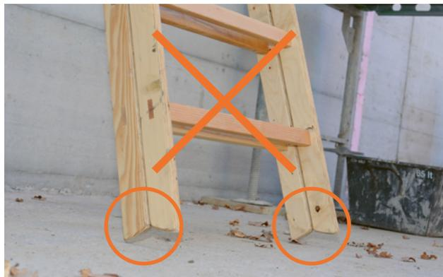
39 Échelle double utilisée comme échelle simple: elle repose uniquement sur le bord du pied.
