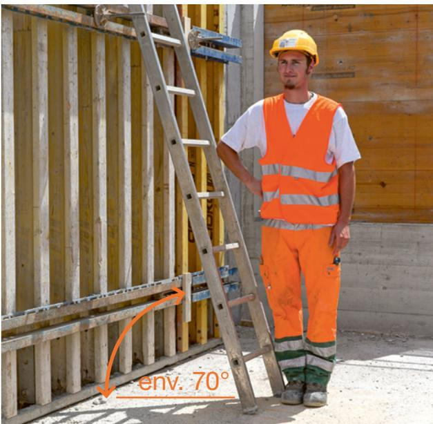
17 Vérification de l'angle grâce au test du coude
