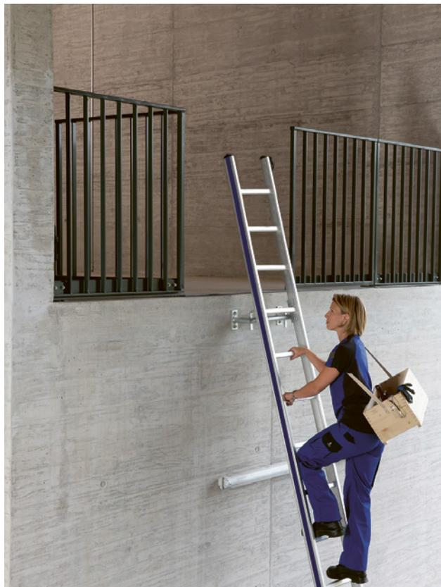
30 et 31 Le regard et le corps vers l'échelle, les mains sur les échelons et un accessoire approprié (trousse ou caisse à outils)
