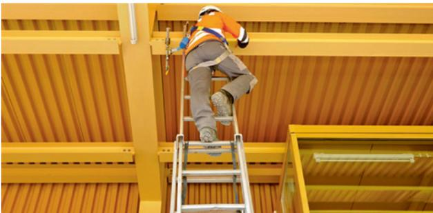
33 Personne sur une échelle assurée par une protection par encordement, point d'ancrage au-dessus de la tête
