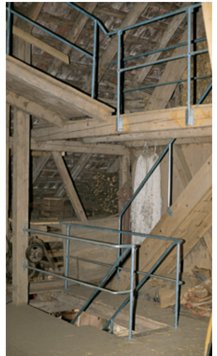
Qui en a la possibilité peut exécuter les balustrades et mains-courantes en métal. Il est souvent plus facile de les adapter aux conditions données.
