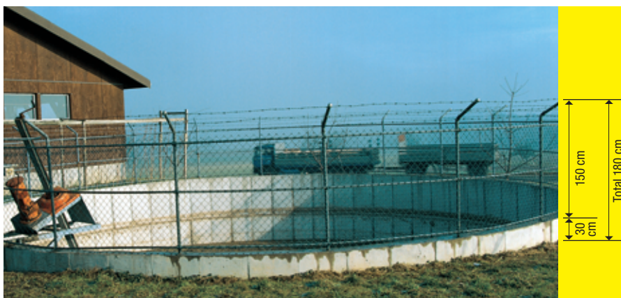
Les fosses à lisier ouvertes doivent être entourées d'un mur ou de treillis jusqu'à 180 cm de haut. Les murs peuvent être verdés aisément. Il faut être attentif que les plantes ou les arbres sur lesquels on pourrait grimper soient à distance suffisante.
