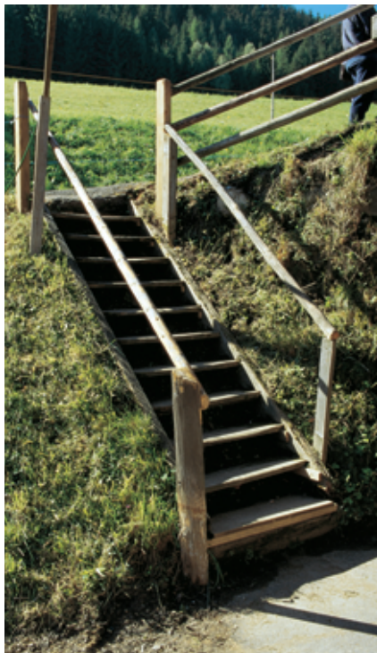
Les escaliers extérieurs doivent être praticables sans risque. Outre des mains-courantes, ils doivent posséder des marches antidérapantes aussi par temps humide ou verglacé.
