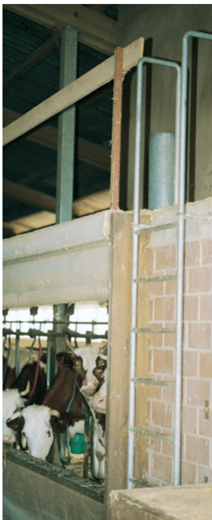
Accès sûr sous la forme d'une échelle verticale fixe équipée de poignées très pratiques ou pour accéder au séchage en grange. La distance entre la paroi et une échelle fixe doit correspondre à 15 cm au moins à l'endroit le plus étroit.
