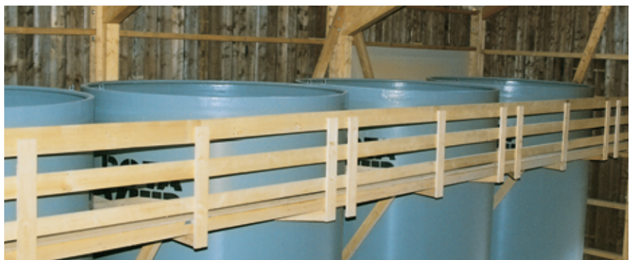
Une passerelle peut aussi être montée à des silos en polyester. Elle doit être placée à 100 cm en dessous du rebord des silos.
