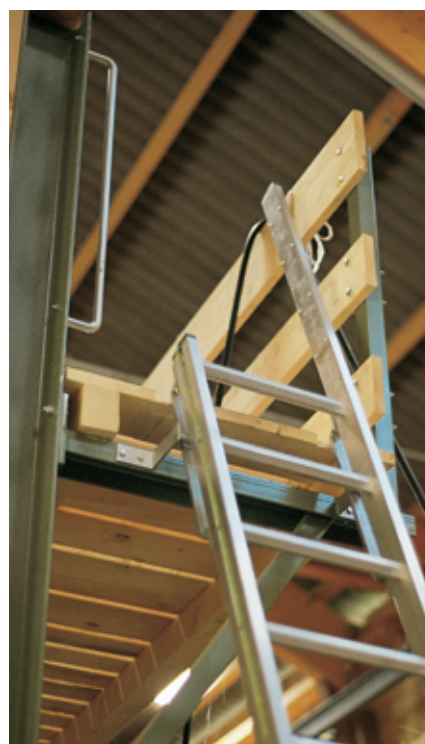
Echelle à crochets pour suspendre à un arceau. Les poignées sont nécessaires pour accéder sûrement à l'étage supérieur.
