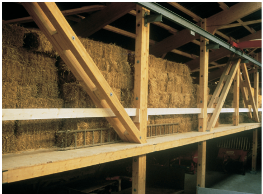
Balustrade intégrée intelligemment à la construction. Elle doit être dimensionnée de manière à résister aux charges attendues.
