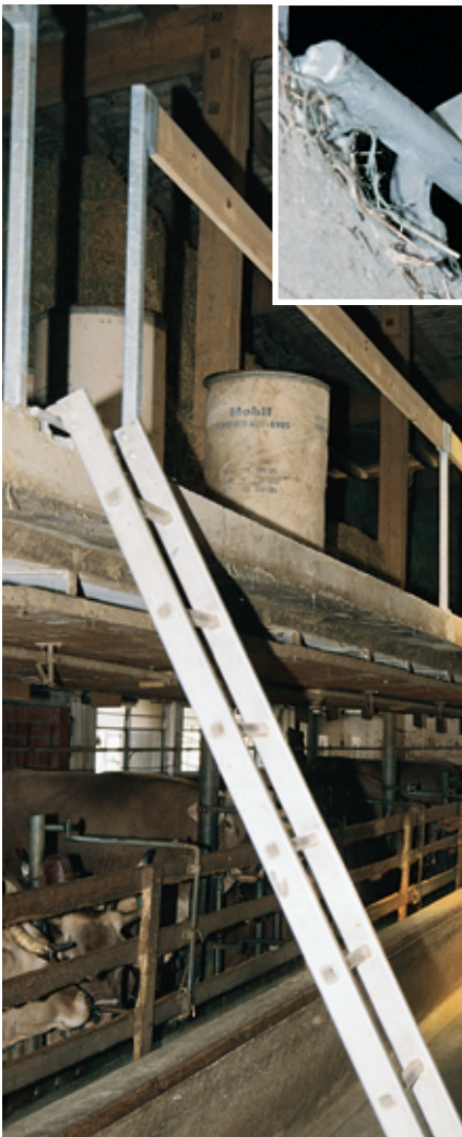
Accès sûr avec échelle mobile et ouverture dans la barrière permettant le débarquement.
