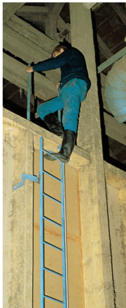
Accès sûr sous la forme d'une échelle verticale fixe équipée de poignées très pratiques ou pour accéder au séchage en grange. La distance entre la paroi et une échelle fixe doit correspondre à 15 cm au moins à l'endroit le plus étroit.
