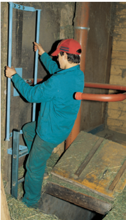
Accès en hauteur sécurisé avec une échelle fixe. L'arceau rouge sert de protection du dévaloir.
