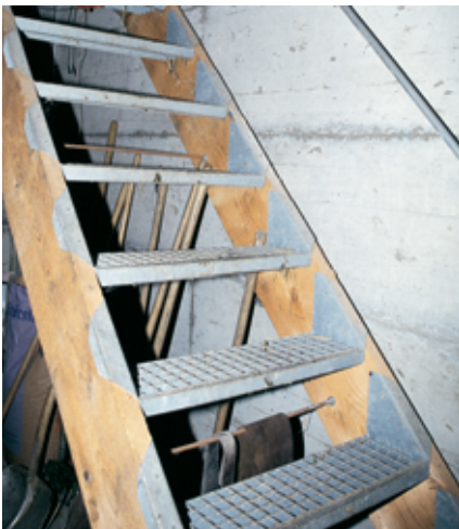
Les escaliers peuvent être construits sur l'exploitation, particulièrement avec des marches préfabriquées qui se fixent aisément sur les limons.
