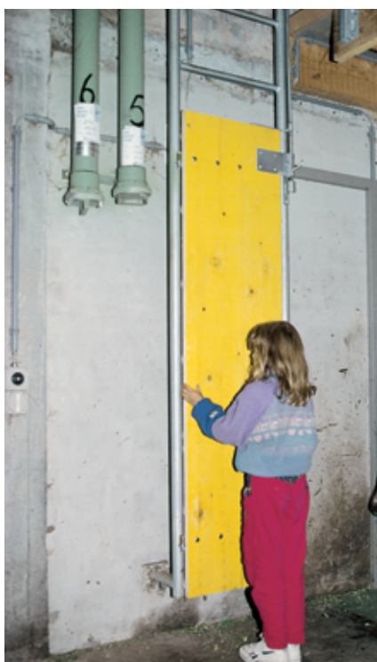
Une planche ou un panneau de coffrage suspendu au bas d'une échelle verticale peut servir de sécurité-enfants.
