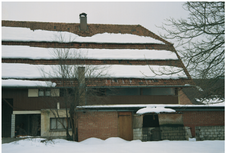
Les paves-neige empêchent les avalanches et protègent à la fois les personnes et les objets. Le propriétaire du bâtiment est responsable des dégâts causés à autrui.
