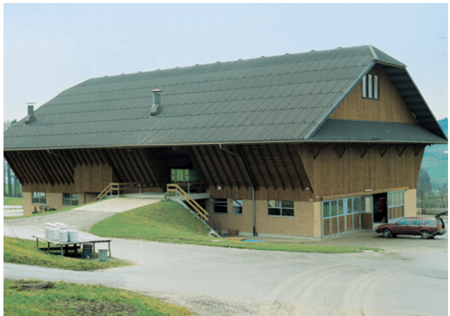
Les bâtiments traditionnels avec le stockage des fourrages sur l'étable présentent de nombreux dangers. Les agriculteurs et les planificateurs doivent veiller à les éliminer. La documentation de construction du SPAA «La sécurité dans la construction et la transformation de bâtiments agricoles» fournit de nombreuses indications et lois.
