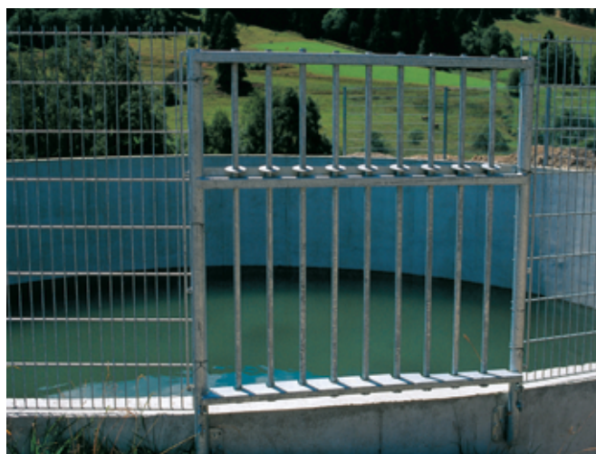
Ces barreaux se relèvent individuellement. Ainsi, la protection est également assurée quand le brasseur mobile est en fonction.
