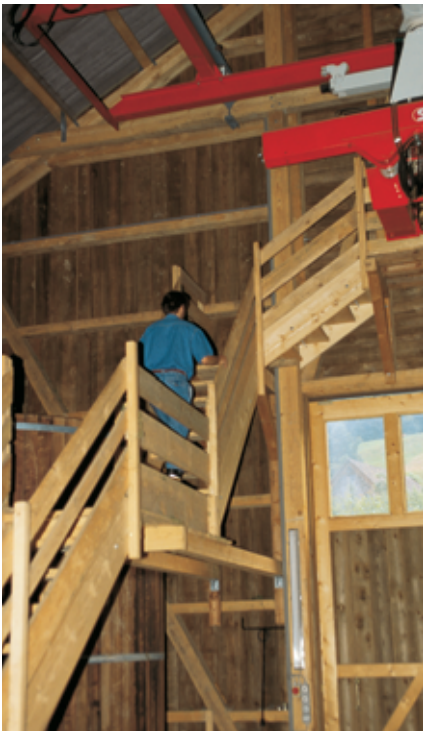
Très bon exemple d'un accès simple au pont roulant. S'il est intégré dès la planification, il se réalise sans problème.
