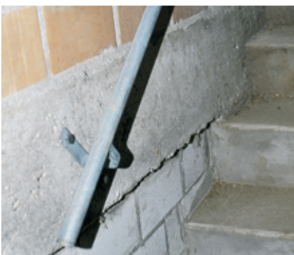
Une main-courante idéale, sur laquelle la main peut glisser sans obstacle.
