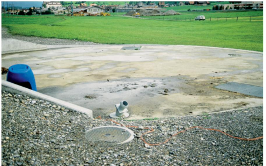
*Pour une nouvelle fosse à lisier, on peut planifier les ouvertures d'aération, de montage, pour le brasseur et le trou de prélèvement de manière optimale. Si le tuyau de prélèvement est placé sur un passage, on doit effectuer moins de marches arrières.*
