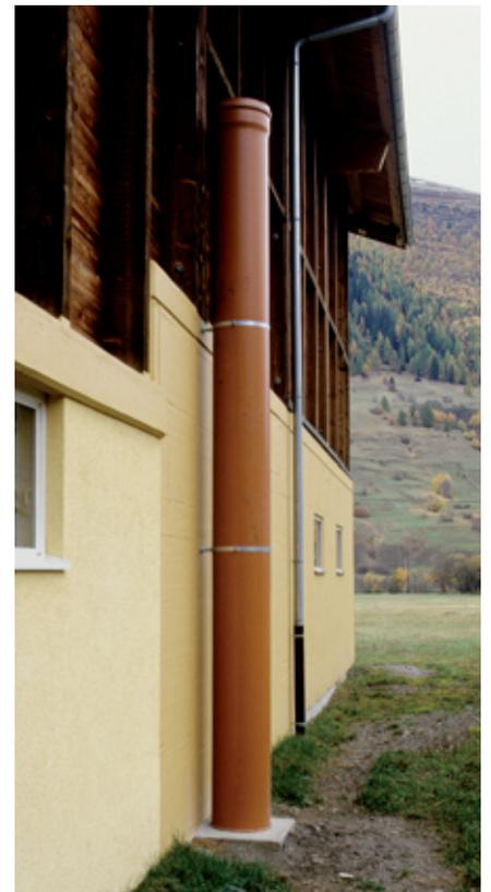
Si les gaz de lisier ne peuvent pas être évacués sans dangers par des ouvertures d'aération, la fosse doit en plus être aérée par un ventilateur.
