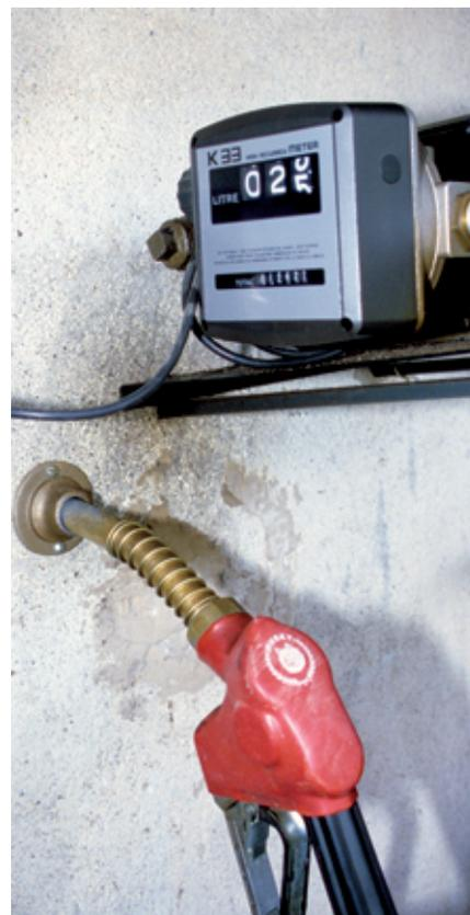
Une station de diesel avec déclenchement automatique aide à éviter les dégâts à l'environnement.
