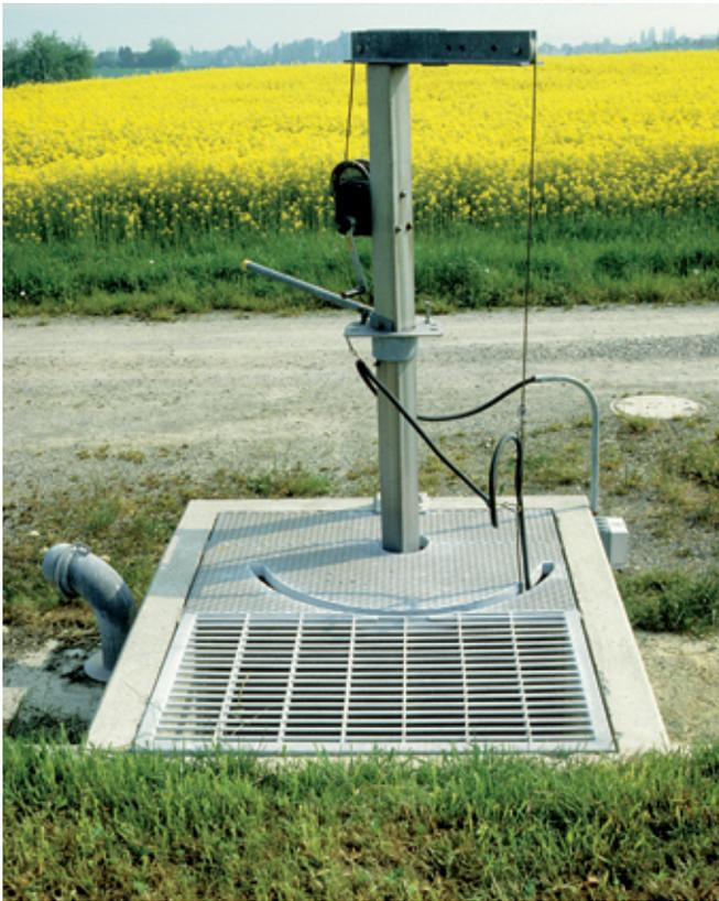
Les brasseurs doivent pouvoir être commandés depuis l'extérieur. Une grille solide permet l'aération et le contrôle de la fosse.
