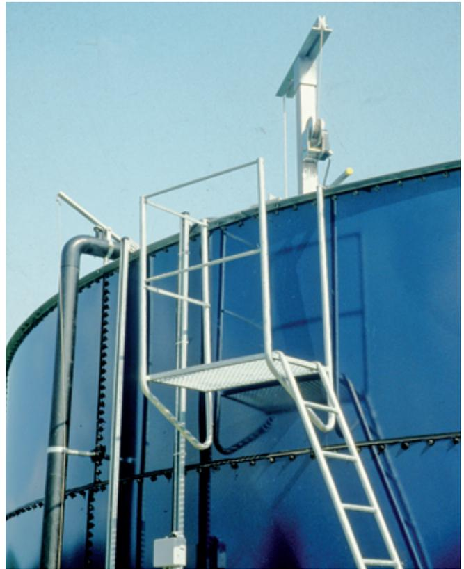
On doit trouver une estrade pour manoeuvrer le brasseur sur un silo à lisier. L'échelle amovible sert d'accès.
