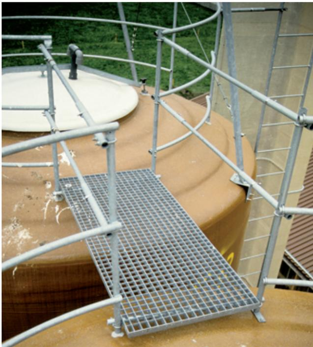
Les silos tours montés côte à côte doivent être reliés par des passerelles.
