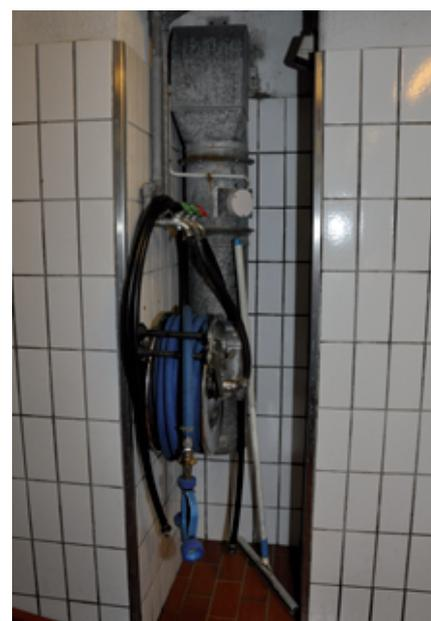
*Une ventilation aspirante fixe est plus confortable. Elle peut être enclenchée par des interrupteurs ou des détecteurs de gaz.*
