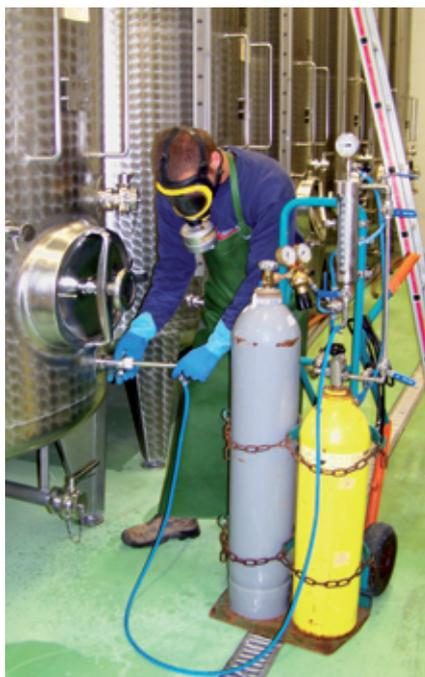
Cette installation permet un usage sûr du SO<sub>2</sub>. On en évite le contact. Il faut porter les EPI nécessaires.
