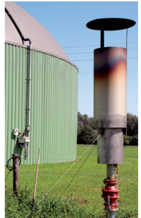
*Les installations de biogaz doivent avoir un deuxième consommateur, par lequel toute la production de gaz peut être brûlée le cas échéant. Le deuxième consommateur doit aussi pouvoir être utilisé lorsque la conduite du réservoir de gaz au consommateur est hors service.*
