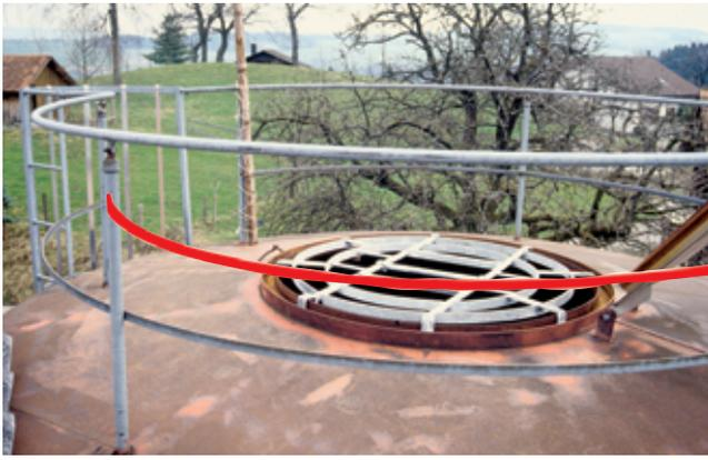
Un dispositif antichute est nécessaire sur l'ouverture de remplissage des silos tours. Un trou permet de passer le répartiteur.
