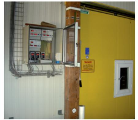
Les chambres AC doivent être munies d'une fenêtre de contrôle, ainsi que des avertissements nécessaires.
