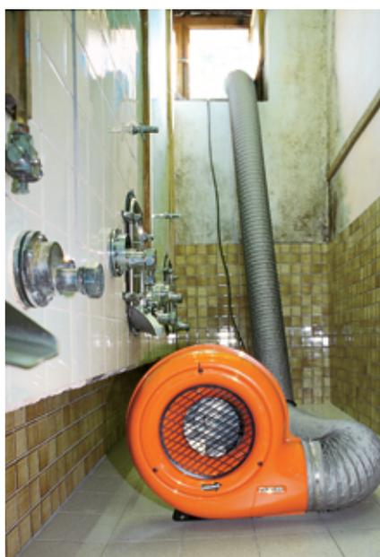
*L'utilisation d'un ventilateur mobile est possible. Il doit être placé avant les fermentations, doit aspirer et doit pouvoir être commandé depuis l'extérieur.*
