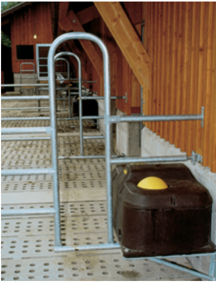
Des passages d'homme (largeur env. 35 cm) doivent être installés dans les barrières et aux extrémités des cornadis dans les stabulations libres.
