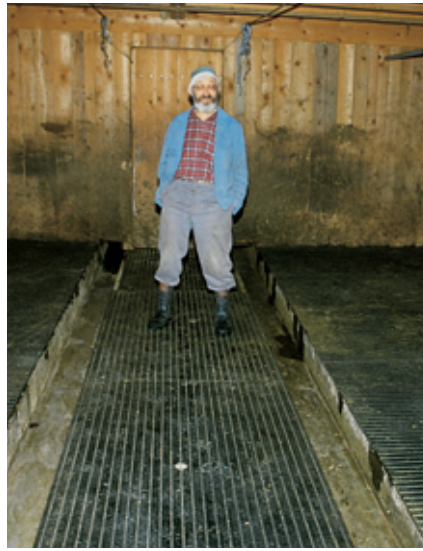
Les sols glissants peuvent être rendus moins dérapants avec des tapis caoutchouc.
