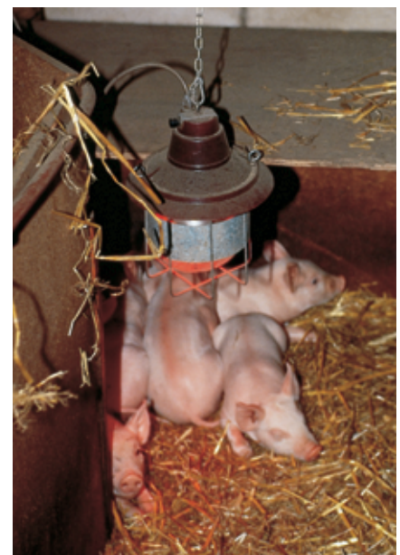
Les lampes à infrarouges doivent être suspendues à une chaîne et munies d'un grillage de protection. Un disjoncteur FI améliore la sécurité.
