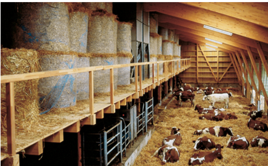
Les plates-formes surélevées doivent être équipées de balustrades. Pour des raisons de sécurité, les balles de paille et de foin ne doivent pas être stockées jusqu'au bord. La balustrade ne gêne pas pour le paillage.
