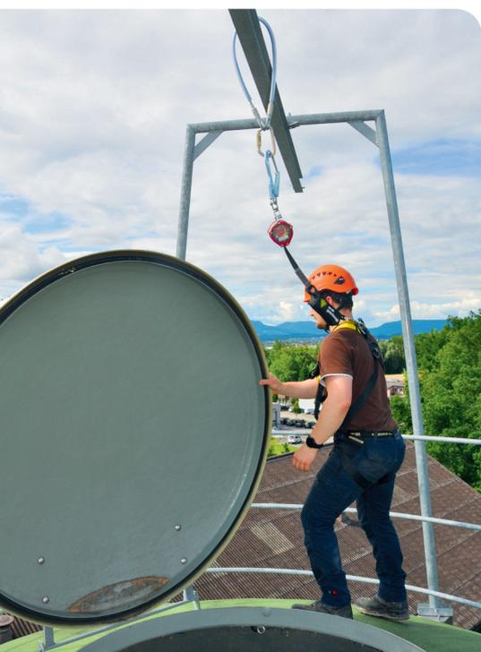
*Assicurare le persone al binario della gru mediante cinghia di ancoraggio, moschettone d'acciaio, dispositivo anticaduta e imbracatura di sicurezza.*
