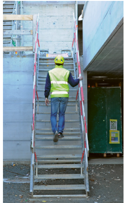
9 Scala a gradini da cantiere
