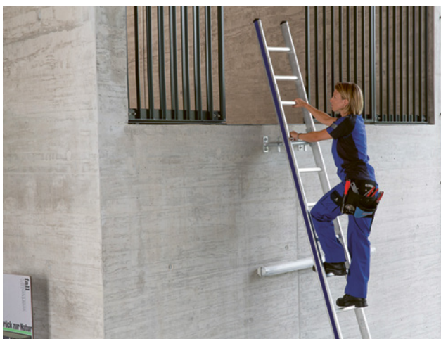
30 e 31 Testa e corpo rivolti verso la scala, mani sui pioli e contenitori adeguati (cassetta o tasca porta-attrezzi)
