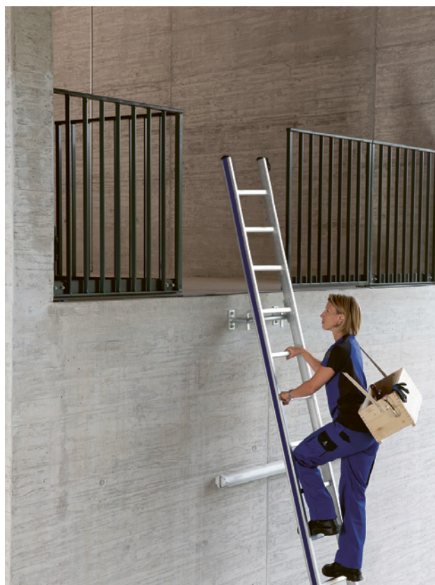
30 e 31 Testa e corpo rivolti verso la scala, mani sui pioli e contenitori adeguati (cassetta o tasca porta-attrezzi)
