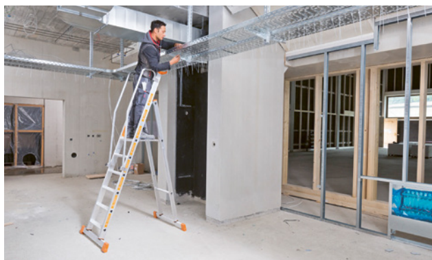
46 Scala doppia a gradini con piattaforma e dispositivo di trattenuta (scala con piattaforma leggera)
