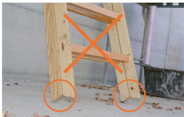
39 Scala doppia usata in appoggio; il sostegno è solo sul bordo dei piedi.
