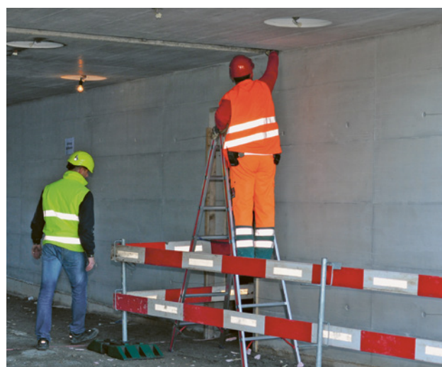
3 Messa in sicurezza della scala in una zona di transito
