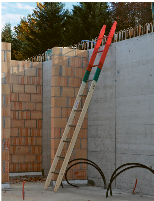
13 Su una scala semplice è vietato salire sugli ultimi tre pioli in alto.
