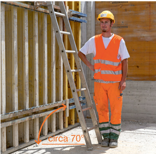
17 Verifica dell'angolo di inclinazione con il gomito
