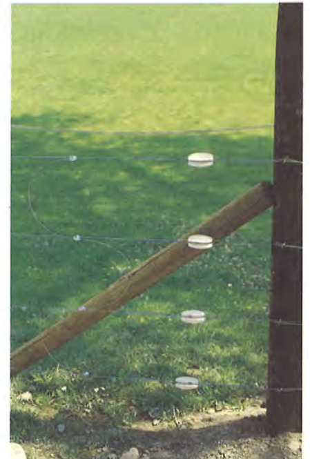
I fili devono essere collegati tra loro in modo da garantire la conducibilità elettrica e da ottenere una superficie di contatto massima.
