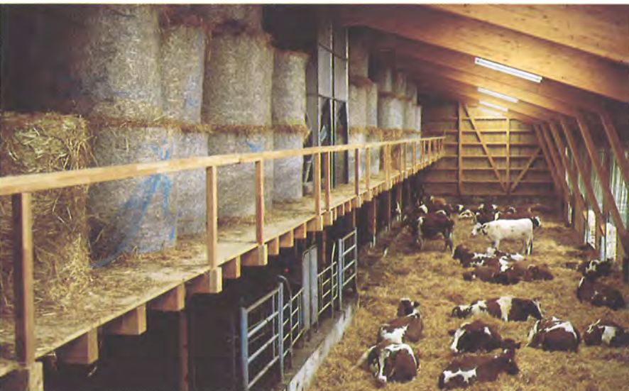
I piani sopraelevati devono possedere delle barriere; per ragioni di sicurezza, non si deve ammucciare le balle di fieno e paglia fin al suo bordo. La barriera non è d'impedimento per mettere la paglia.
