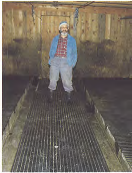
I pavimenti scivolosi possono essere resi meno pericolosi con la posa di tappeti di gomma.
